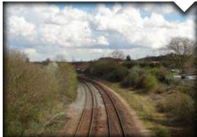
La voie ferrée vue depuis le pont rue de Longpré
